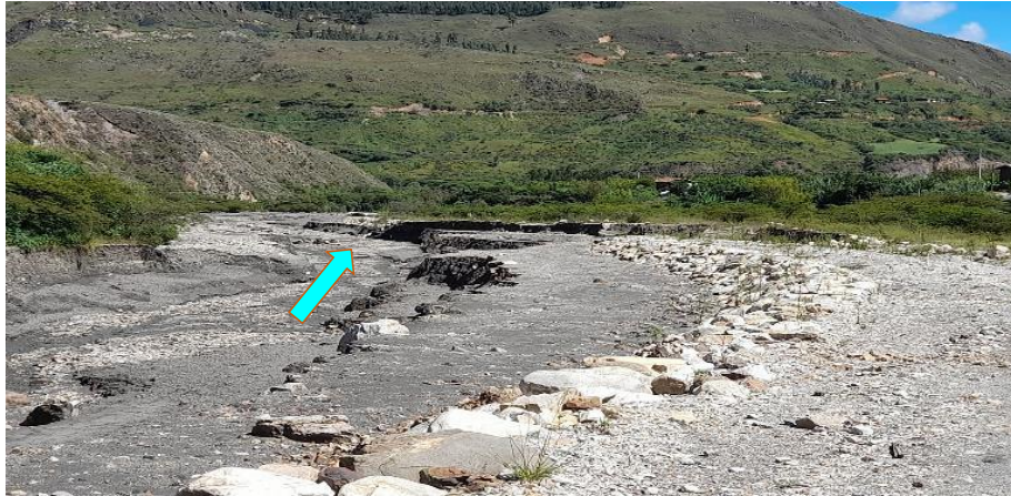
FIGURA N°01: TRAMO CRÍTICO EN LA QUEBRADA NEGRA SECTOR EL OLIVO SE APRECIA LA COLMATACION QUE EXISTE ASI COMO EL ENROCADO EXISTENTE Y SE PRETENDE CONFORMAR DIQUE CON ENROCADO EN LA MARGEN EROSIONADA PRODUCTO DE LA MAXIMA AVENIDA
